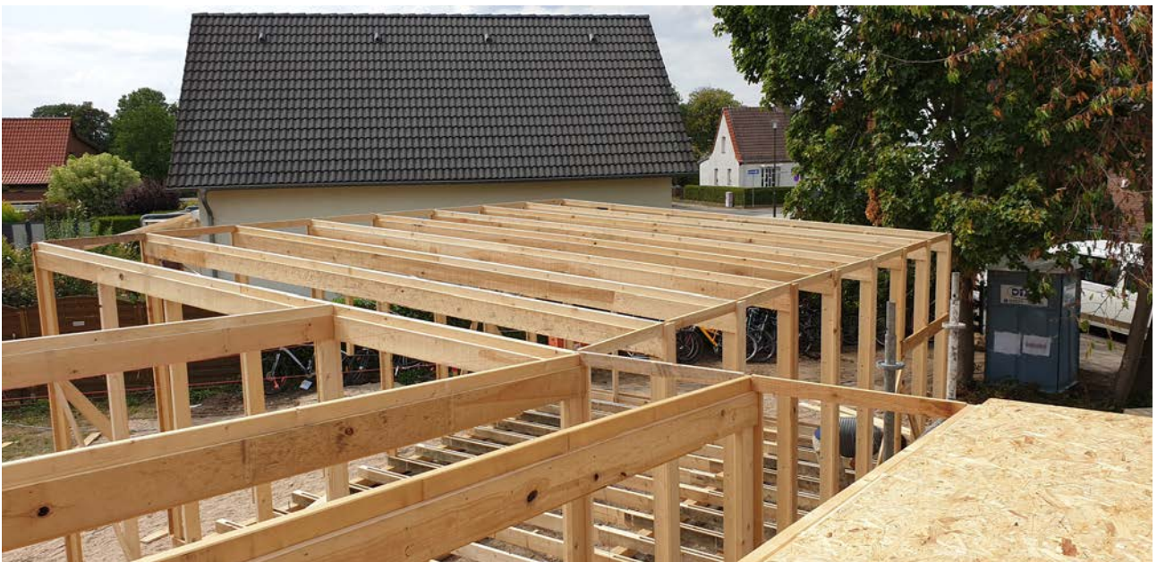
An der Schnittstelle der beiden Raumvolumen entsteht geometrisch bedingt eine Kehle
