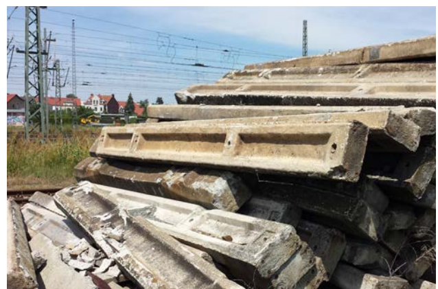
Betonschwellen auf einem nahegelegenen Lagerplatz der Deutschen Bahn AG
