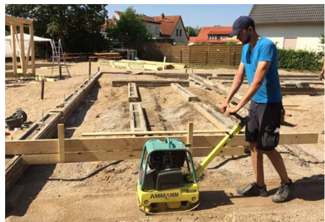
Der zu lockere Untergrund musste verdichtet werden
