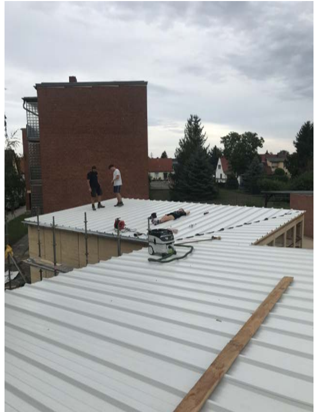
Trapezblech bildet eine kostengünstige und demontable De- ckung
