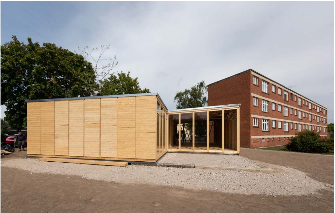
Das Laubenganghaus und der Flachbau bilden zusammen einen exemplarischen Ausschnitt der vom Bauhaus geplanten Mischbebauung
