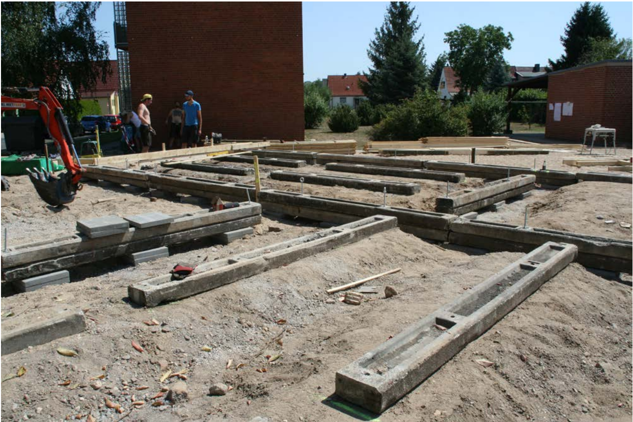
Die Betonschwellen wurden nach Plan auf dem verdichteten Untergrund versetzt und mit Gewindestangen gekoppelt
