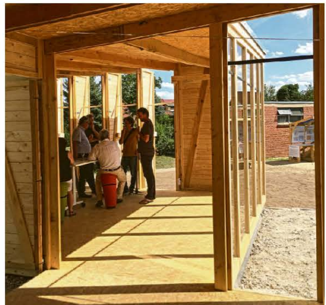
Hölzerne Moderne: während der Bauphase des wachsenden Hauses
